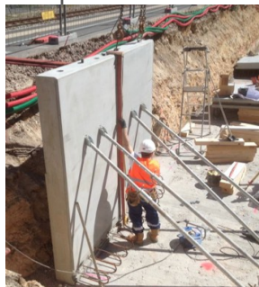
Préparation et pose des rampes
