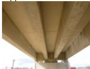
Quadri poutres en BA
