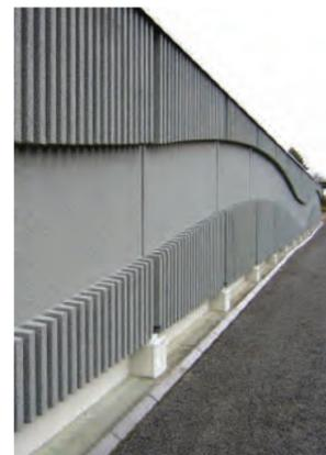
Béton de caoutchouc (recyclage de pneus)
