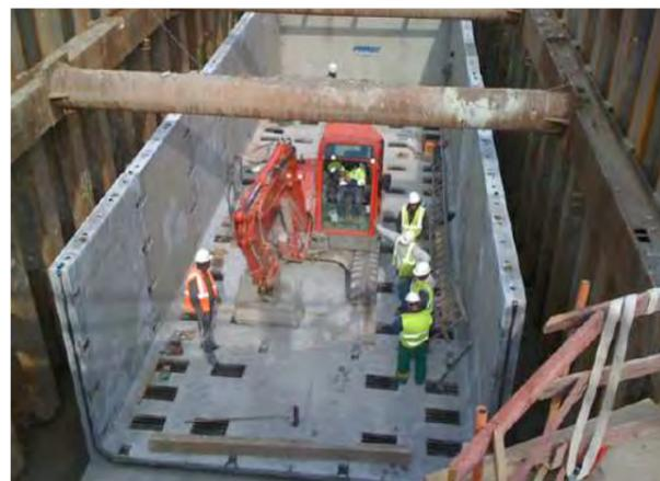
Pose en profondeur avec accessibilité réduite
