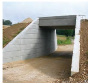
Murs d'entonnement d'ouvrage courant
