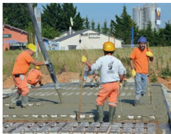
Photo 68 - Coulage du béton sur les moules ViaVerde®
