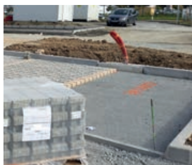
Photo 79 - Lit de pose en gravillons.
