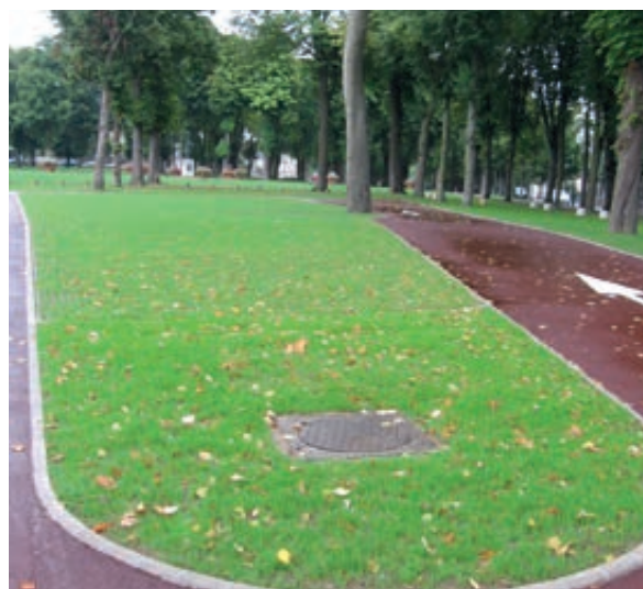
Photo 87 - Revêtement en dalles drainantes engazonnées.
