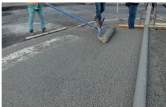
Photo 50 - Compactage au rouleau lesté.
