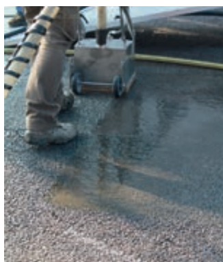
Photo 100 - Le nettoyeur aspire la boue produite.
