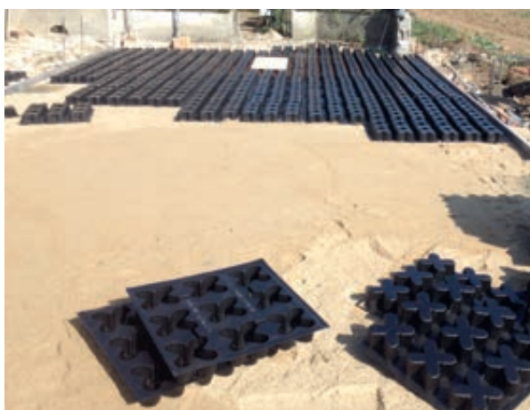
Photo 64 - Pose des moules (système Grasscrete®).
