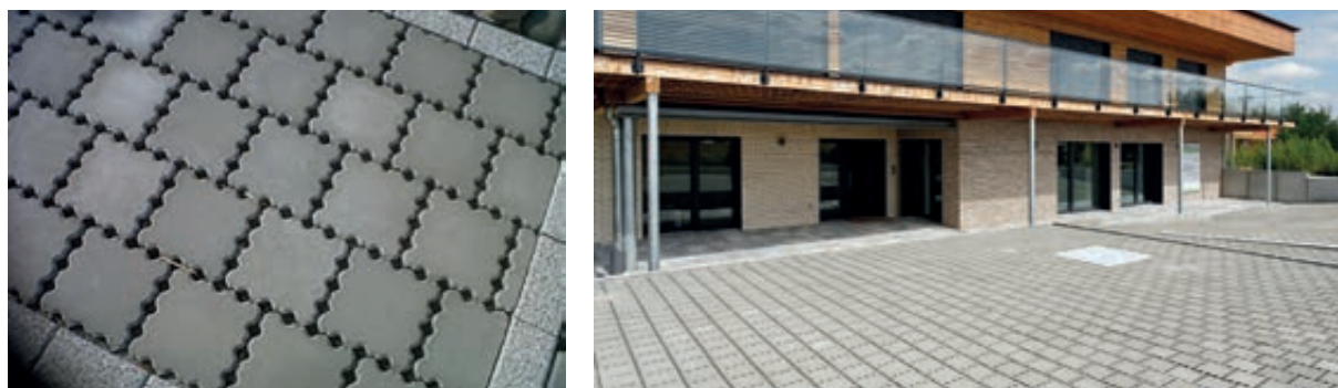
Photos 32 et 33 - Exemples de pavés perforés.
