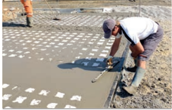
Photo 70 - Talochage du béton (système ViaVerde®)
