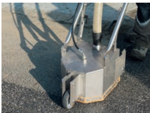
Photo 99 - Le nettoyeur injecte de l'eau sous pression.
