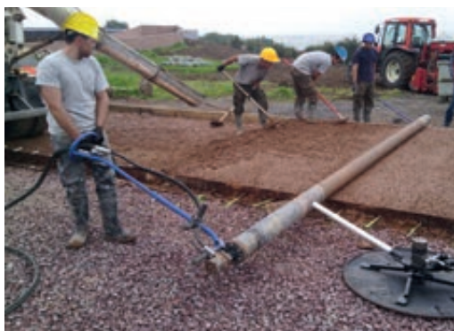
Photo 46 - Coulage du béton et réglage au « roller-striker ».
