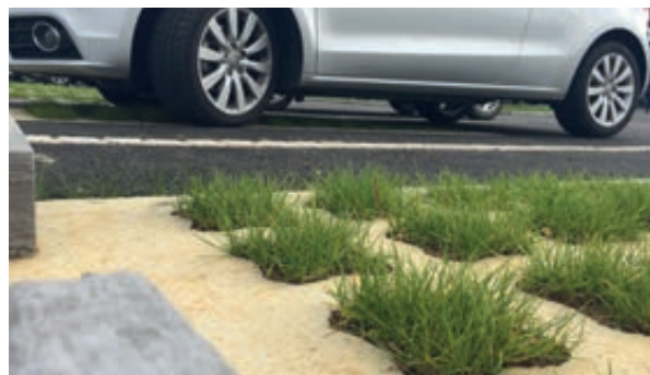
Photo 74 - Engazonnement des alvéoles (système ViaVerde®).
