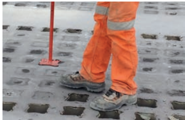
Photo 72 - Désoperculage du système ViaVerde®.
