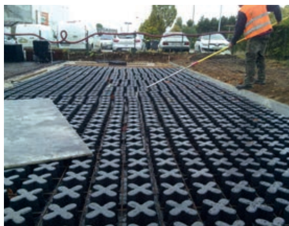
Photo 65 - Réalignement des moules (système Grasscrete®).
