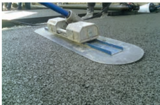
Photo 51 - Passage de la lisseuse vibrante.
