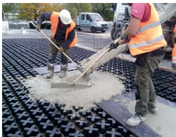
Photo 67 - Coulage du béton sur les moules Grasscrete®
