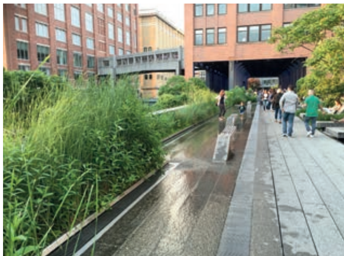
Photo 15 - Passage en produits préfabriqués avec brumisateurs.
