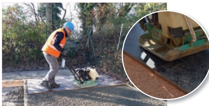
Photo 53 - Compactage au patin vibrant.
