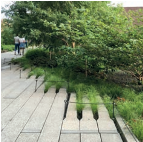
Photo 6 - Noue paysagère associée à un revêtement en produits préfabriqués.
