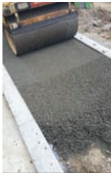
Photo 55 - Compactage du béton drainant.
