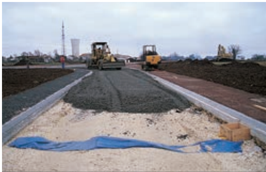
Photo 54 - Répandage du béton drainant à la niveleuse.
