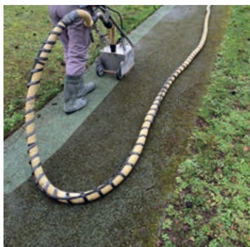
Photo 94 - Nettoyage par pression d'eau suivi d'aspiration.
