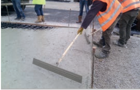
Photo 69 - Répandage à la raclette (système Grasscrete®)
