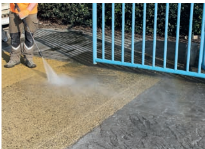
Photo 93 - Lavage au nettoyeur haute pression.
