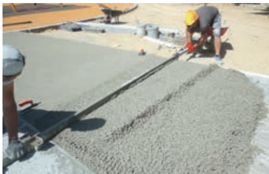
Photo 48 - Nivellement à la règle manuelle.
