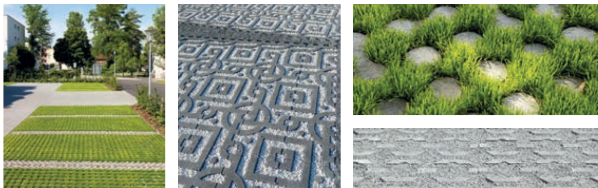
Photos 34 à 37 - Exemples de dalles drainantes engazonnées ou gravillonnées.
