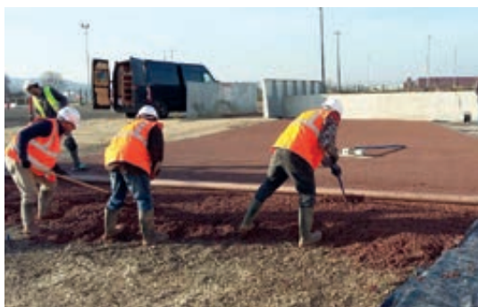
Photo 52 - Nivellement au roller-striker.
