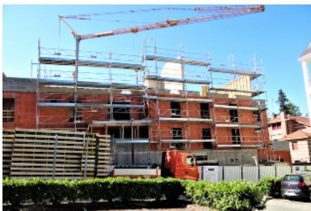
Maçonnerie de brique en façade, en bloc béton en murs séparatifs et acrotères de GBR
