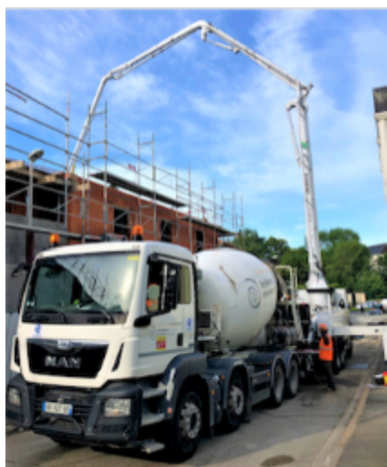
Coulage de la dalle en béton prêt à l'emploi de GBR
