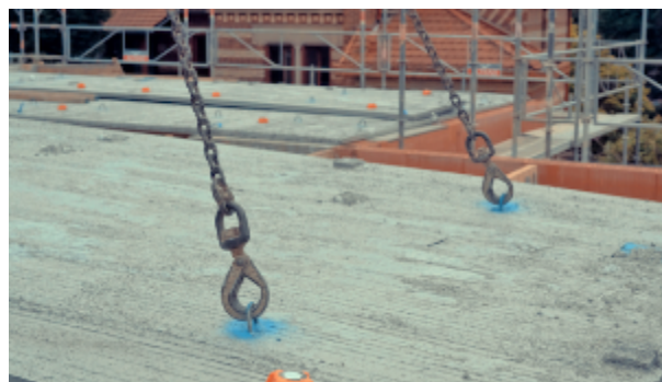
Livraison et pose des Prédalles préfabriquées en béton précontraint (non GBR, la réglementation ne le permettant pas encore)
