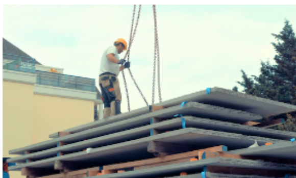
Livraison et pose des Prédalles préfabriquées en béton précontraint (non GBR, la réglementation ne le permettant pas encore)
