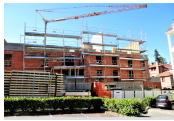
Livraison et pose des ossatures bois
