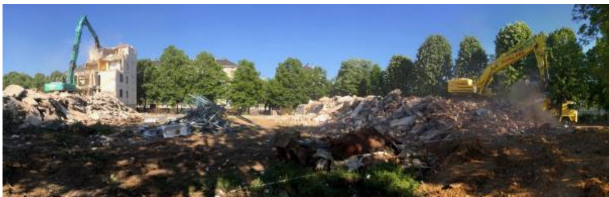
Vue d'ensemble d'un chantier de démolition
