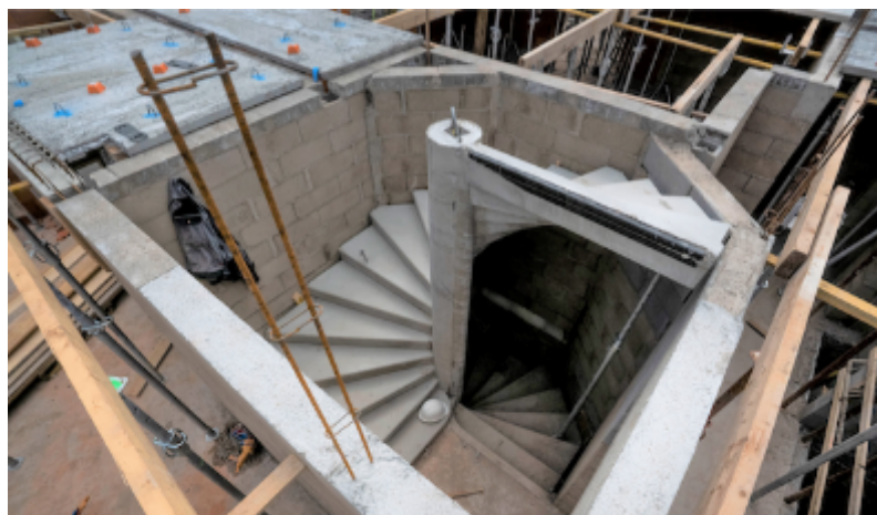
Escaliers préfabriqués en béton de GBR
