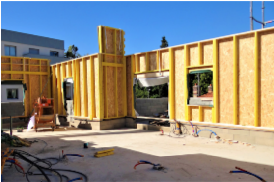
Pose des ossatures bois
