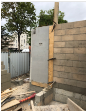
Prémurs préfabriqués en béton matricé de GBR
