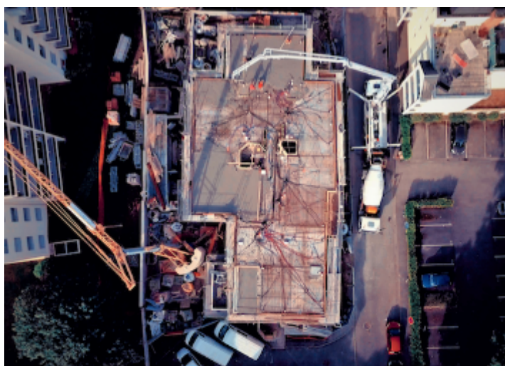
Coulage de la dalle en béton prêt à l'emploi de GBR
