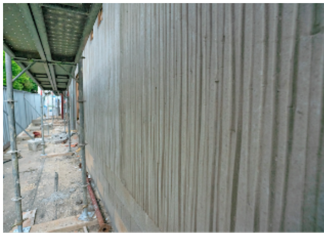
Prémurs préfabriqués en béton matricé de GBR
