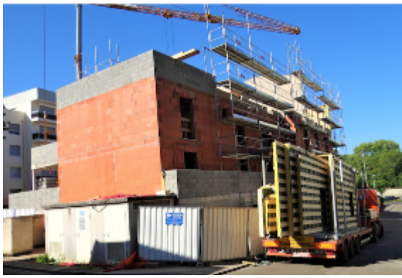
Livraison et pose des ossatures bois
