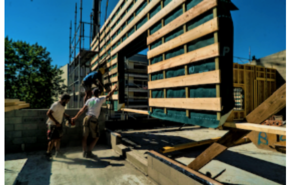
Pose des ossatures bois
