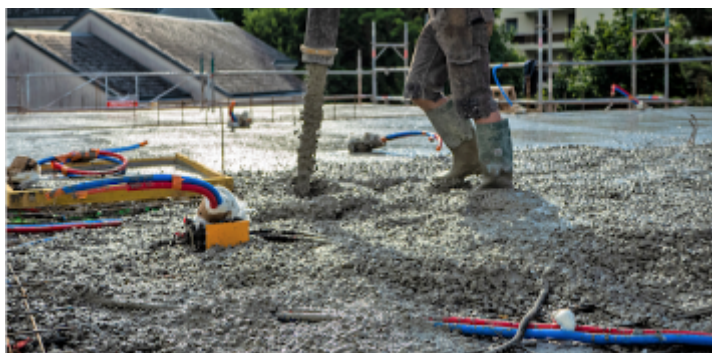
Coulage et lissage de la dalle de GBR
