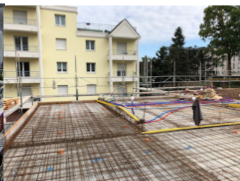
Ferraillage du plancher
