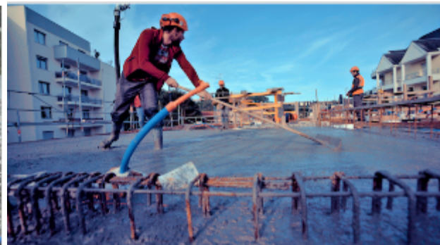
Coulage et lissage de la dalle de GBR
