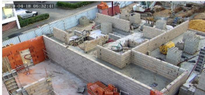
Maçonnerie en blocs béton de GBR
