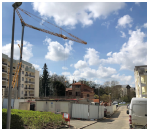
L'emplacement du chantier (mars 2019)
