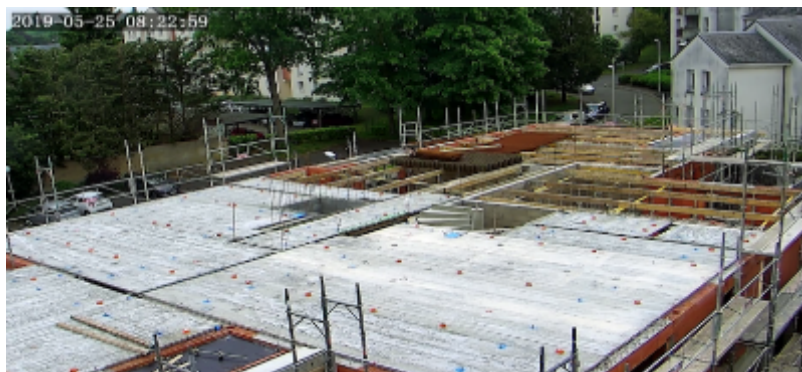
Predalles posées sur étais
