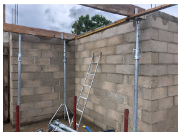
Maçonnerie de brique en façade, en bloc béton en murs séparatifs et acrotères de GBR
