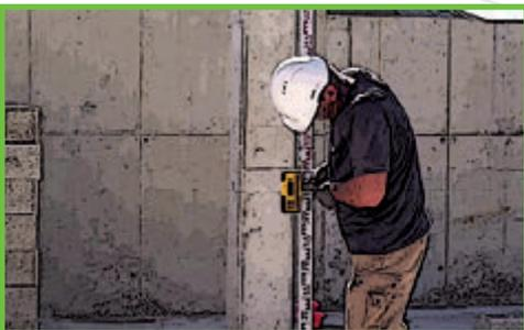
**12** Utilisez le laser pour contrôler l'altimétrie entre vos deux blocs.
