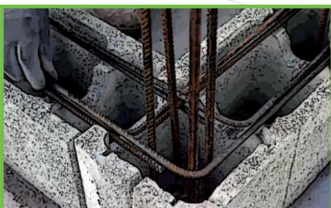
**5** Positionnez les étrépages de ferrillage pour assurer la continuité des armatures dans les angles.
