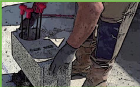
**11** Faites de même de l'autre côté et positionnez les blocs accessoires au droit des chaînages verticaux intermédiaires. L'ajustement à la longueur des murs se fait ainsi par un bloc accessoire pour coupe ou une coupe sur un bloc entier en partie courante.
