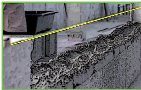
**7** Posez votre mortier avec la même technique afin d'obtenir un joint régulier et sans rupture.
