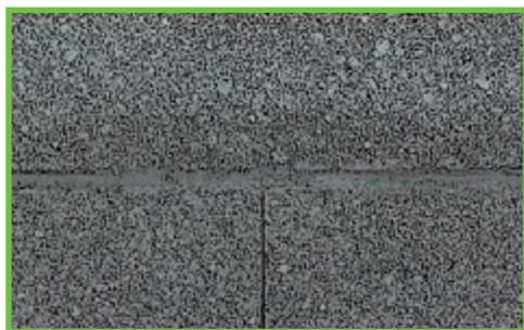
**10** L'épaisseur finale de joint doit être comprise entre 1 et 2 cm.
