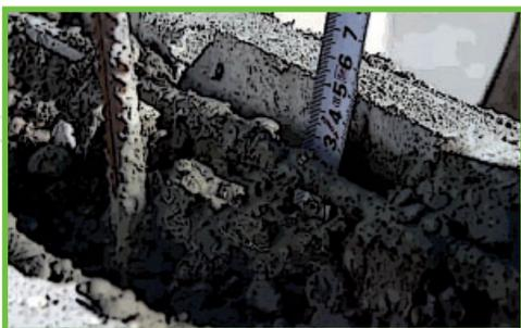
**14** Arasez le béton 5 cm plus bas que l'arase en attente afin d'éviter une reprise de bétonnage au droit d'un joint horizontal entre blocs.
