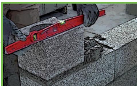
**5** Faites de même sur l'angle opposé ou au niveau du chaînage vertical intermédiaire.
