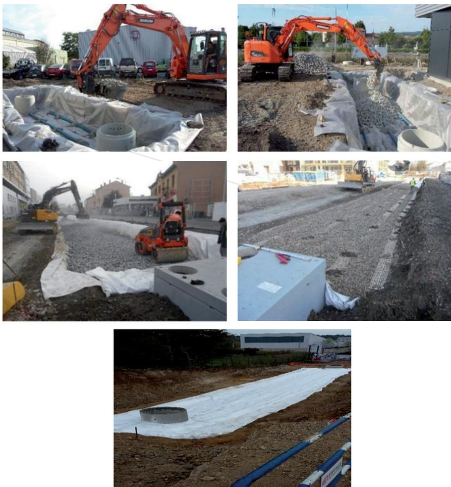
Figure 37 – Étapes de mise en place d'une structure réservoir en produits creux préfabriqués en béton (Hydrocyl®)
