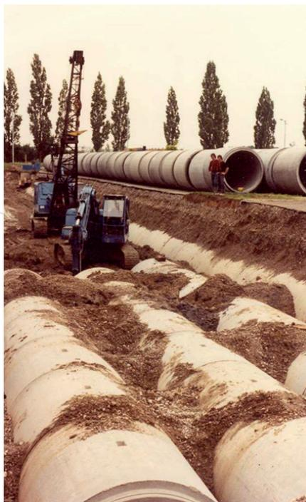
Figure 29 – Exemple de pose multiple de canalisations de grand diamètre, sans respect des distances entre tuyaux
