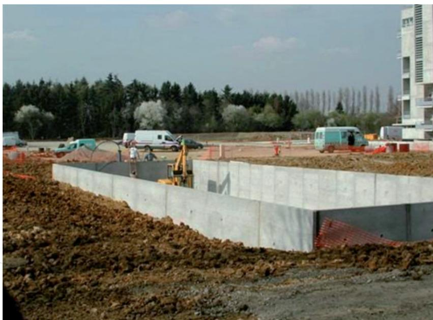
Figure 22 – Bassin en murs préfabriqués assemblés [Chapsol]
