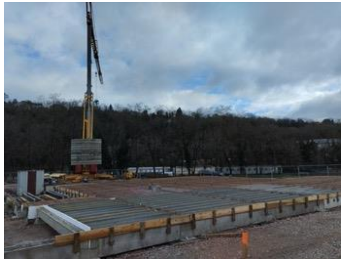
Le chantier du Creusot – KP1
