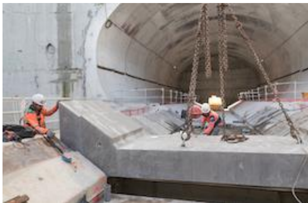
Travaux Métro ligne 14
