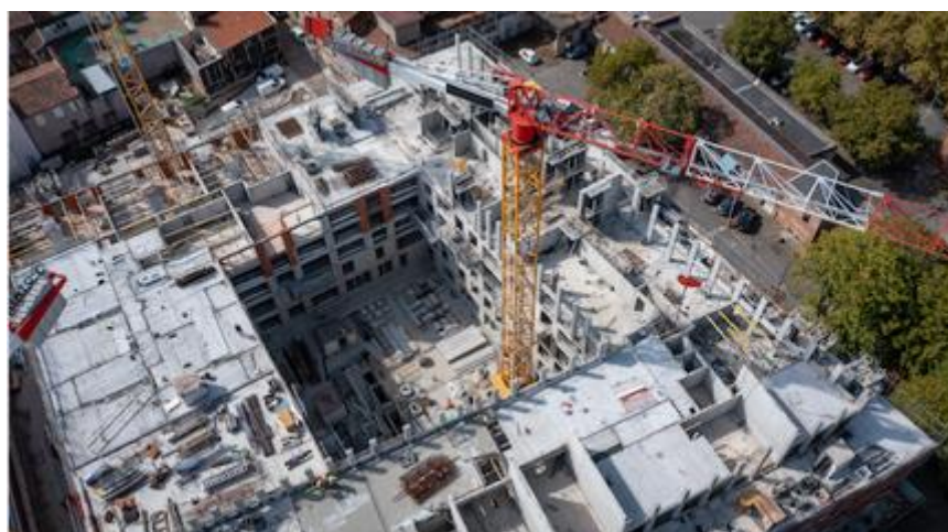
Vue aérienne du chantier démonstrateur Résidence Olympi à Chartres
