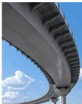
Poutres de pont
