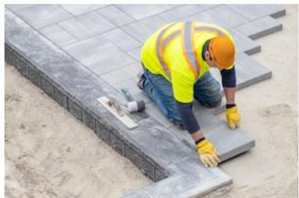
Pose d'un dallage
