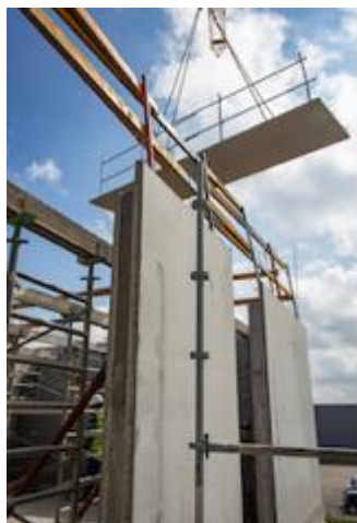
Pose de prémurs
